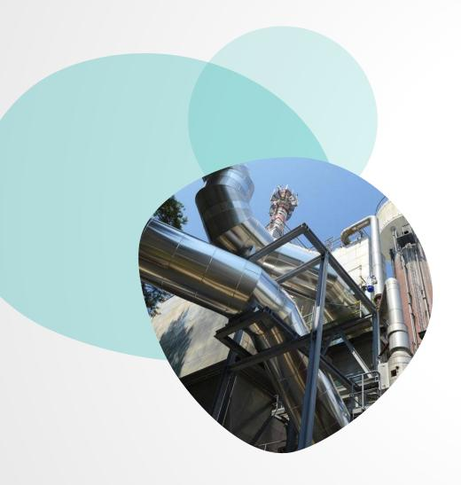
Das Sechs-Millionen-Euro-Projekt wurde von der Stadt Neuburg als "Leuchtturmprojekt" gestartet. Aus der Glasproduktion werden jährlich **24 Mio. KWh Wärme** abgegeben; dadurch werden 2,4 Mio. Liter Heizöl oder **6.300 Tonnen Kohlendioxid** eingespart. Benachbarte Industriebetriebe (bspw. Donau-Malz, AUDI) werden beliefert.
